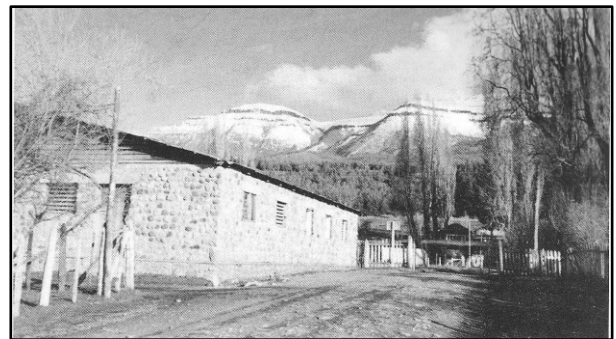
Foto N° 6 Primer piso cocinas de peones, 1992 revista C.A. N° 70.
