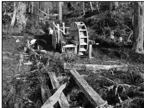
Figura 1. Antiguo aserradero movido con fuerza hidráulica donde se explotó madera de N. pumilio y N. betuloides , Cerro Negro - Provincia de Coyhaique. Ruedas de madera (para el agua y la polea), postes del canal y basas donde se ubicaba la sierra circular. (Fotografía del autor 2010)
